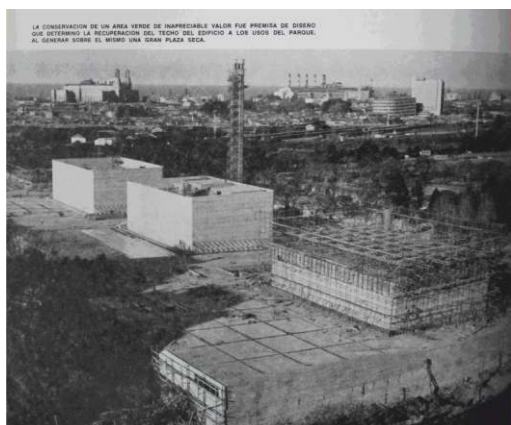
Fig. 1. El edificio del Centro de Producción Buenos Aires en construcción (1977, noviembre-diciembre. Revista Construcciones, 268)
