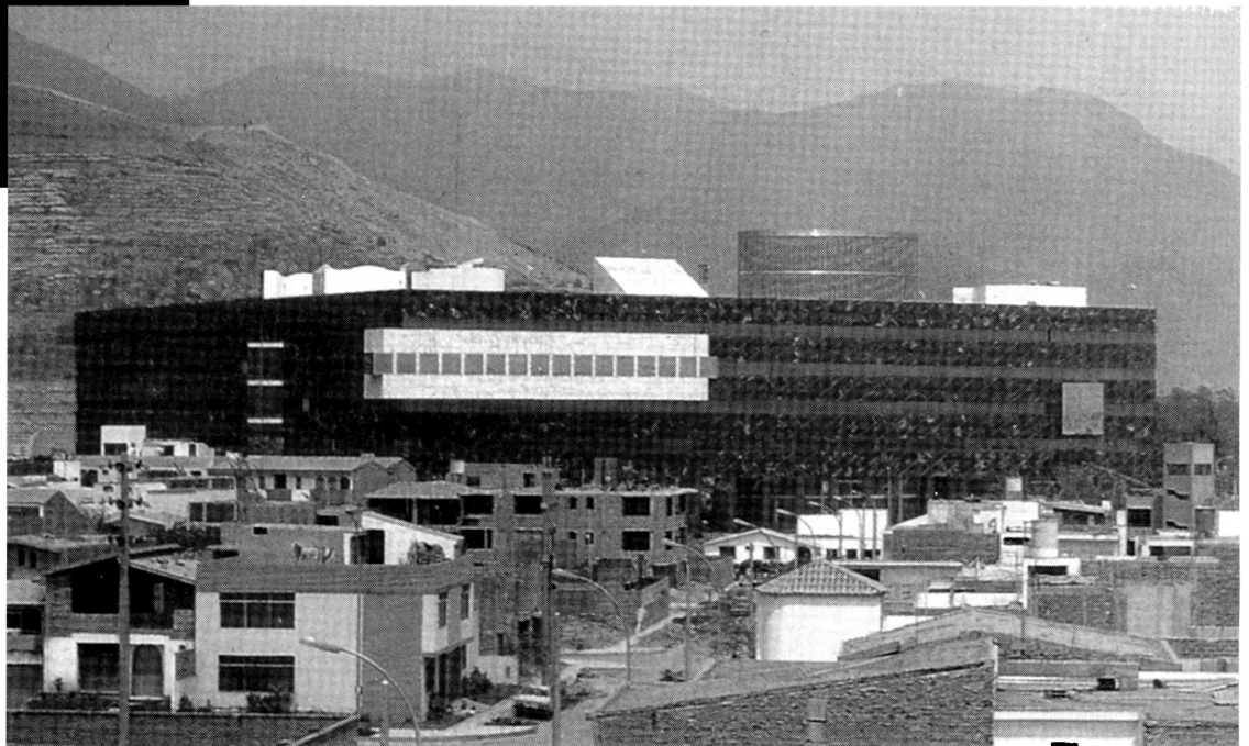
Banco de Crédito de Perú. Lima, Perú. Arquitectónica: Fort-Brescia, Spear, Romney, arquitectos
