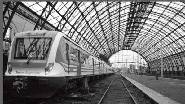
Nave de arcos triarticulados, de acero. Estado de abandono. Se ha retirado la cubierta, y esto ha corroido la estructura. RESTAURACION.
