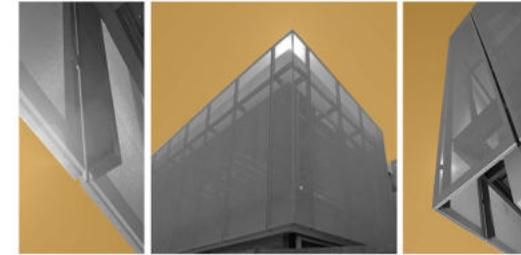
El sistema de fachada textil está compuesto por dos componentes: la membrana y la estructura. La membrana es un material perforado de un tejido de poliéster de alta tenacidad recubierto por PVC. La estructura está compuesta por bastidores de aluminio con bordes de perfiles o cabos en zig-zag.
