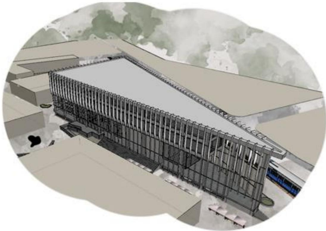
El edificio esta compuesto por una estructura principal de losas postensadas para lograr cubrir grandes luces y permitir flexibilidad en las plantas, el cual responde a una concepción de espacio contemporaneo.
