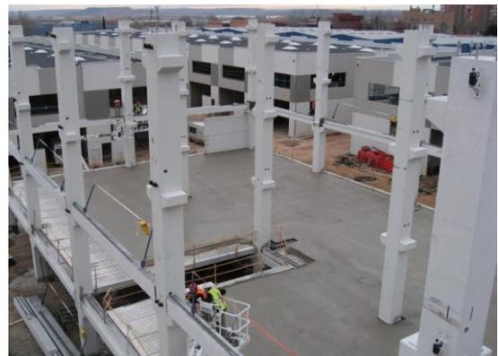
Este sistema constructivo brinda todos los elementos necesarios para la materialización del proyecto, posibilitando una rapidez en el proceso de montaje, disminución de costos presentes en la ejecución de hormigón armado in situ, reducción de costos y tiempos de obra al contar con elementos prefabricados con calidad certificada, eliminando sistemas de control de calidad presentes en la ejecución de hormigón armado in situ.
