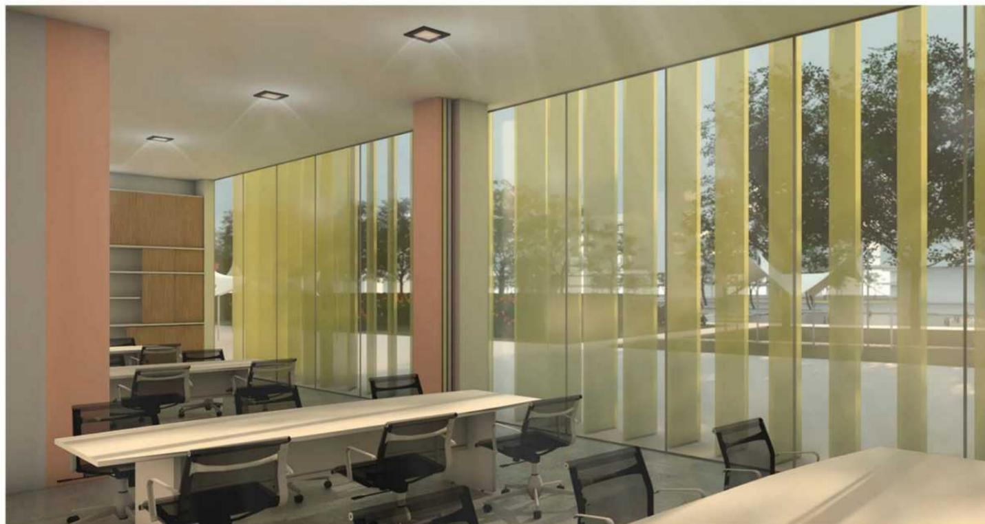
Paneles acústicos corredizos, a través de una guía ubicada en el cielorraso, permitiendo diferentes configuraciones.
