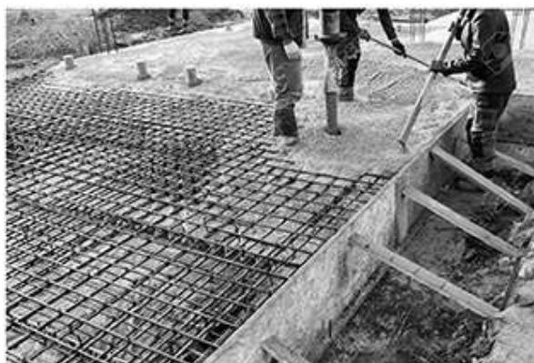
SUELO ARCILLOSO CON MUCHA HUMEDAD, AGUA A POCA PROFUNDIDAD. LAS PLATEAS ACTÚAN COMO PLANOS RÍGIDOS Y TIENEN LA PROPIEDAD DE REPARTIR UNIFORMEMENTE LAS CARGAS SOBRE EL TERRENO
