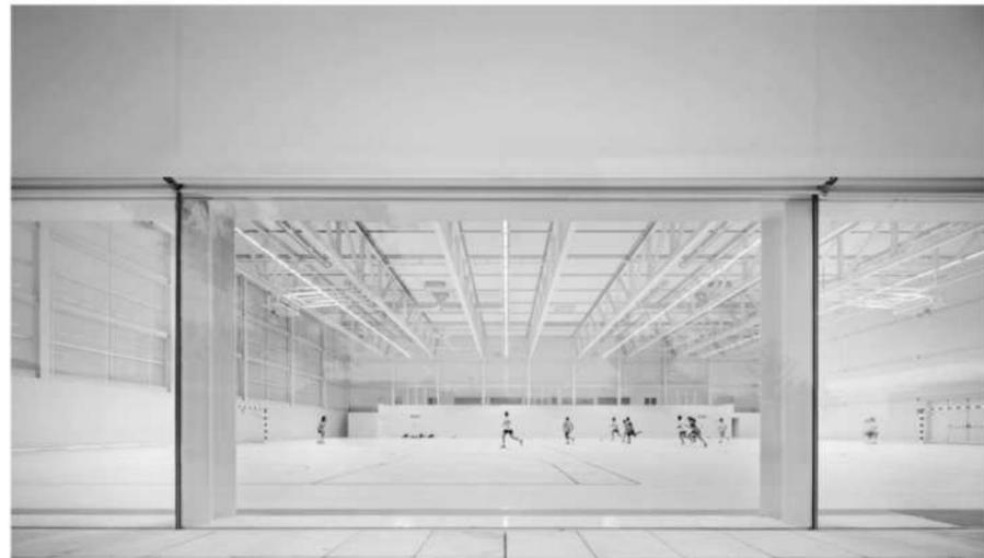
La estructura del pabellón se construye en acero: una retícula de pilares y vigas en fachadas y cerchas para resolver las grandes luces de cubierta. Todo pintado en blanco. El resto de la estructura es de hormigón armado, con la singularidad de vigas de gran canto sobre el espacio de las piscinas en sótano.
