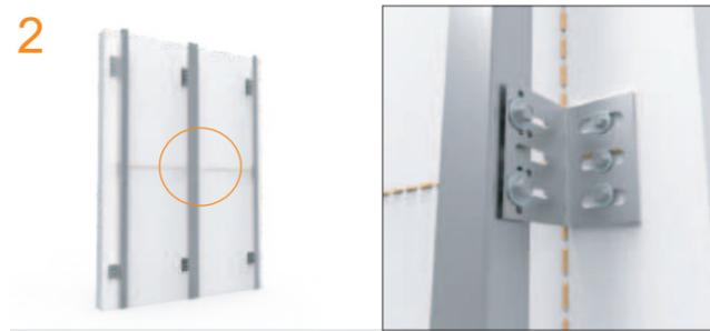
2. Pre-posicionar los perfiles de soporte L y T mediante la trabazón que se produce por la alternancia de escuadras. Esto permite mantener el perfil en su posición antes de fijarlo a las escuadras. Fijar utilizando autoperforantes #10x5/8" HWH, primero extremos superior e inferior y luego intermedias, en el siguiente orden: primero en ojo chino y luego en punto fijo.
