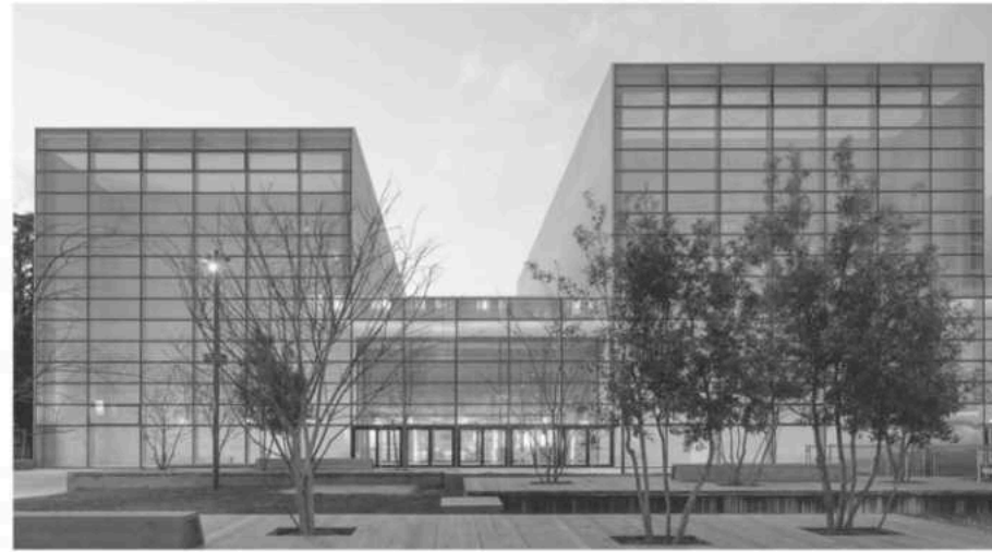
Teatro Nouvelle Comédie de Genève / FRES Architectes / Suiza / 2021
