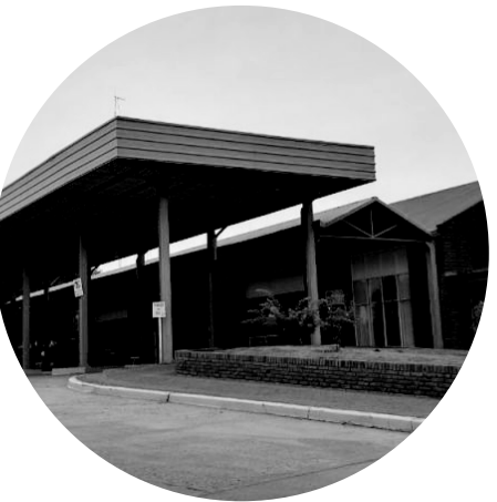
H TERMINAL DE COLECTIVOS DE CARLOS CASARES
