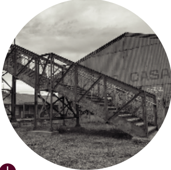
I • Predio Ferriario de Carlos Casares
