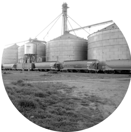
D SILOS DE ACOPIO CEREALERA PRIVADA
