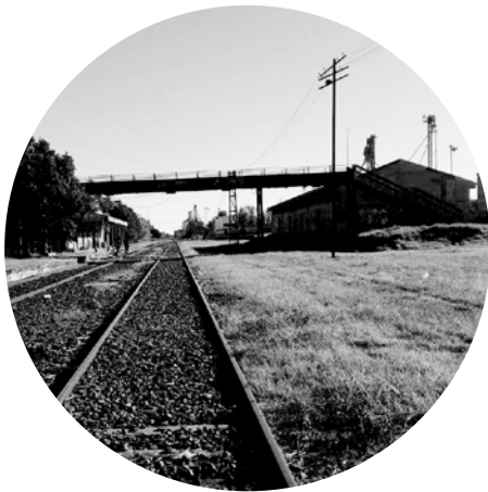
I PUENTE DE LA ESTACIÓN DE TRENES DE CARLOS CASARES
