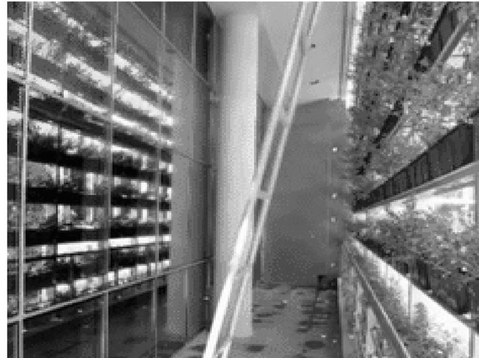
De esta manera el verde obra de “tamiz” de la excesiva radiación solar de la fachada noroeste, siendo complementada con protecciones horizontales (losa en voladizo de 1,4 m) y protecciones verticales interiores que busca permitir instancias sucesivas y flexibles de luz u oscuridad según sea el requerimiento y las condiciones meteorológicas.
