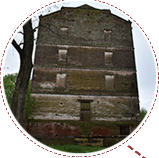
PAREDES PORTANTES DE LADRILLO
