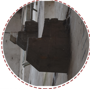
REVOQUE PARCIAL EN MAL ESTADO
