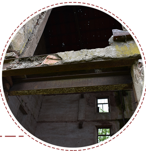
DINTELES DE DOBLE PERFIL METALICO
