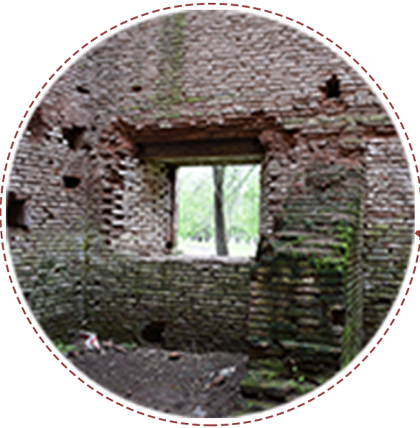
PAREDES PORTANTES DE LADRILLO
