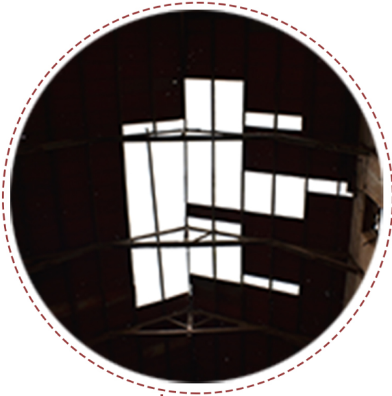
CUBIERTA DE CHAPA CON FALTANTES PARCIALES
