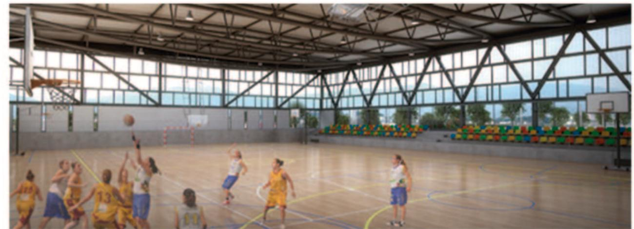
De construcción ligera **metálica** y fachada de U-Glass que permite de día establecer reflejos y de noche lo convierte en una lámpara. Enfatiza su condición de equipamiento público. Los servicios de apoyo de **hormigón armado** que sirve también para arriostrar de la
