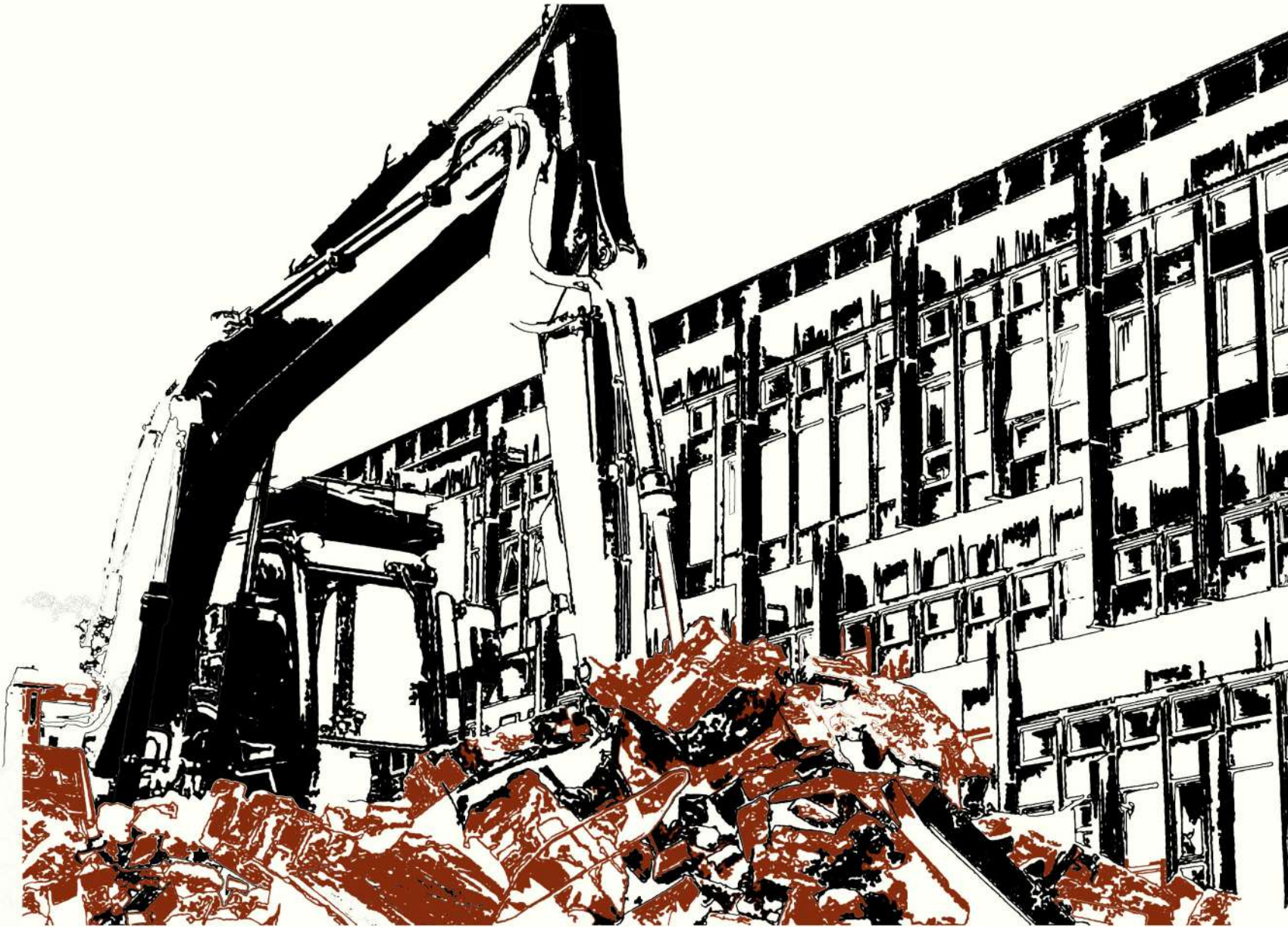
Demolición de Robin Hood Gardens / Peter & Alison Smithson. . 23 de agosto de 2017
