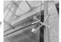
De vidrio sostenida por un sistema Spider y una estructura secundaria de perfiles metálicos
