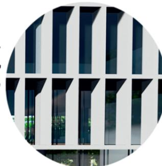
PARASOLES DE HORMIGÓN ARMADO, DEL LADO NOROESTE, ASÍ FILTRANDO LA LUZ SOLAR DIRECTA EN LAS AULAS
