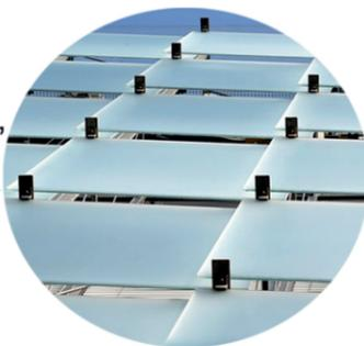
ENVOLVENTE DEL TELÓN DE FONDO, DE DOBLE VIDRIO, AISLANTE DEL FRÍO Y EL CALOR
