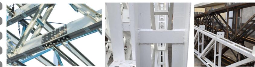
Las imágenes muestran las soldaduras y las uniones que se realizan en las vigas reticuladas la unión de las dos partes de vigas reticuladas que se hace en obra para después montar estas en las columnas.
