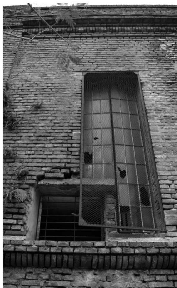
Las carpinterías metálicas existentes presentan alto grado de deterioro. Presentan lesiones químicas (**corrosión y oxidaciones**) y mecánicas (**fisuras**) principalmente. Los vidrios se encuentran en gran parte rotos y se evidencia la presencia de **organismos** vegetales. Las principales causas son la falta de mantenimiento y un proyecto deficiente para las nuevas intervenciones.
