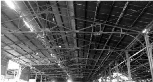
La cubierta existente se compone por **chapa ondulada** que se apoya sobre una estructura de perfiles u dispuestos sobre las cabriadas.
