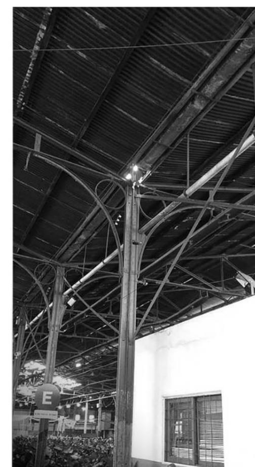
La estructura puntual compuesta por columnas metálicas (rieles ferroviarios compuesto) se encuentra en **buen estado** general. Solo presentan deterioro en el acabado final preexistente por lo que requiere poca intervención para su reacondicionamiento. Las mismas son atravesadas por el desagüe pluvial.
