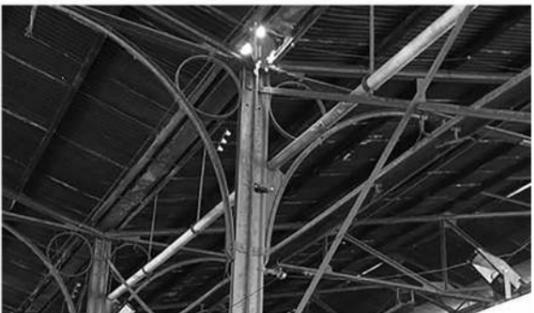
La estructura puntual se compone por columnas conformadas a partir de **rieles ferroviarios compuestos**. Estas se organizan en una modulación de 17m x 5m, conformando 3 filas de columnas que se complementan con el muro portante de ladrillo.
