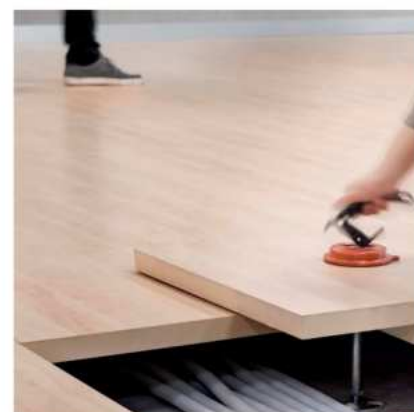
DESMONTAJE CON SOPAPA
