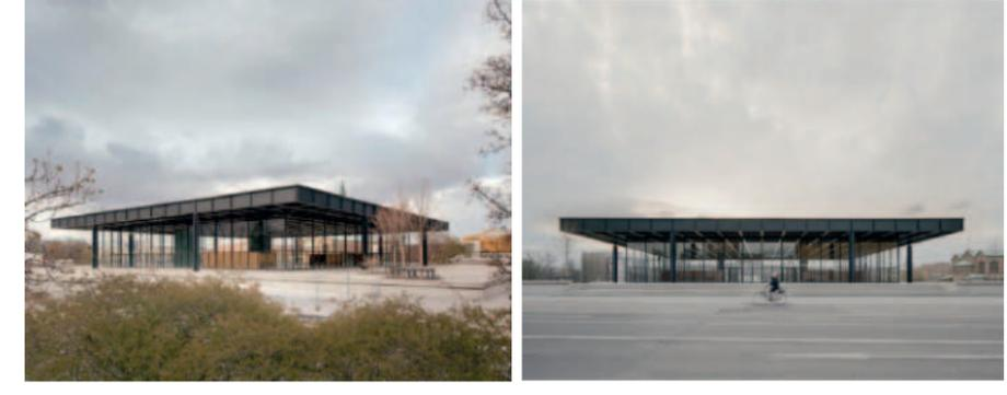
Punto de interés: Arquitectura y estructura. Es un edificio que exalta la abstracción de la **forma y la función** en su más puro ensamble, permitiendo deslumbrar en su diseño **soluciones sencillas** para problemas complejos. Conformar una gran cubierta sostenida por apoyos en su perímetro y un entramado de vigas metálicas.
