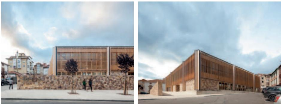
Punto de interés: Arquitectura y tecnología sostenible. Es una estructura de **madera laminada** compuesta por piezas cortadas en taller y ensambladas en obra. La cubierta, junto con las cuatro cajas de servicio que emergen del suelo, conforman la infraestructura necesaria que permite que se produzcan **múltiples eventos**, tanto de manera espontánea como programada, bajo un mismo techo.
