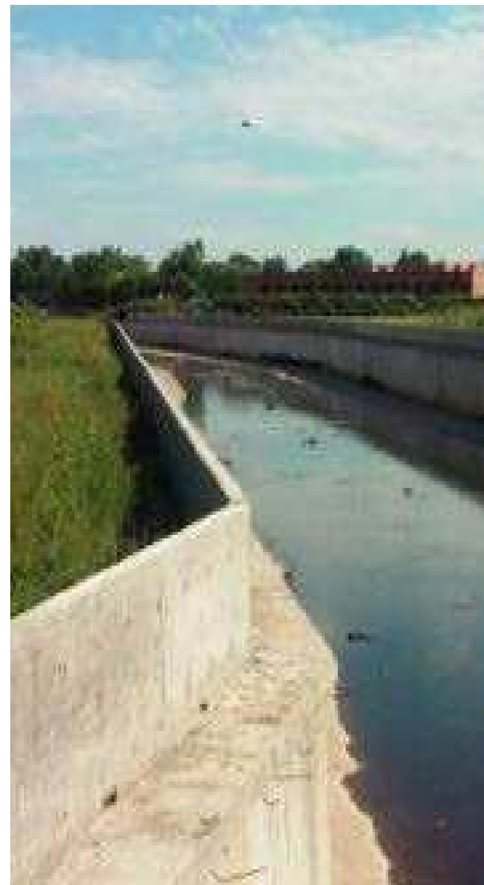
Obra hidráulica de canalización del Arroyo El Gato
