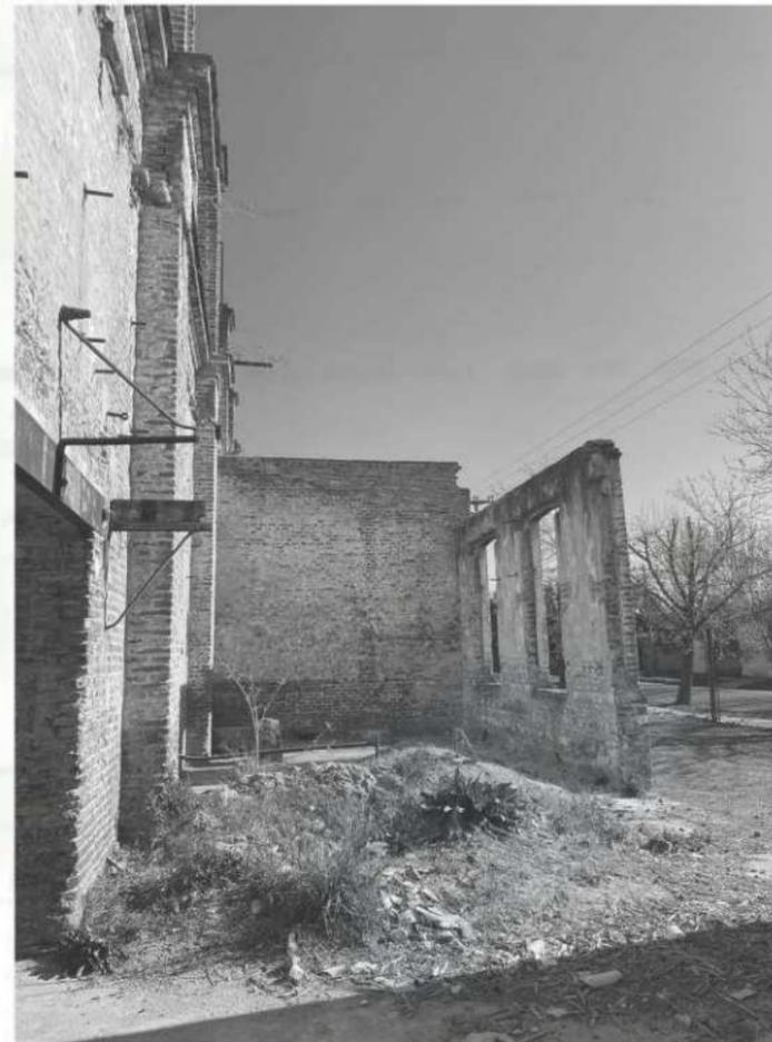
DERRUMBE DE LA CUBIERTA DE LA NAVE ADOSADA Y FALTA DE MUROS
