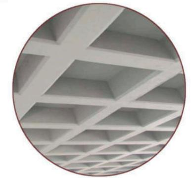
El emparrillado de hormigón armado es utilizado en todos los niveles del edificio. Es una estructura bidimensional que trabaja a flexión y corte. Permite cubrir grandes luces lo que posibilita flexibilidad funcional requerida. Sobre los nervios se dispone una losa que funciona como cruzada y empotrada en los nervios de 10 cm de espesor. Cada 30 mts se coloca una junta de contracción para evitar grietas irregulares.
