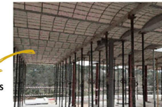
Los ladrillos se disponen alternados sobre un bastidor metálico, en un panderete donde se ubican enteros y medios apoyados unos sobre otros sin sustancia que los ligue
