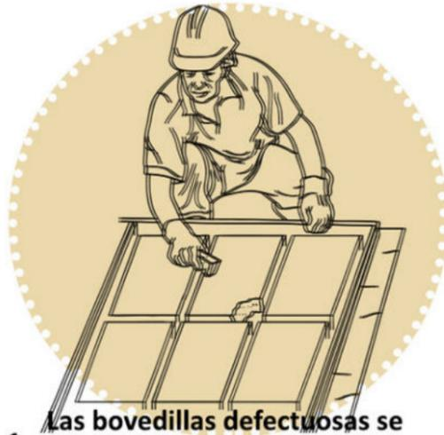
1 Las bovedillas defectuosas se colocan en la hilera del medio
