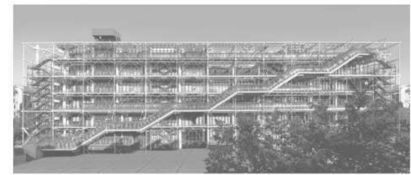
El museo fue concebido como un gran container vacío, moldeable según las necesidades de cada evento, y rodeado por una envoltura tecnológica compuesta por los sistemas técnicos que sirven a ese gran espacio: la piel de vidrio con sus vigorosas estructuras metálicas de soporte, los conductos y equipos de acondicionamiento de aire y las escaleras mecánicas que conectan los diversos niveles del edificio.
