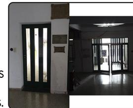
8) EL EDIFICIO CUENTA CON PISOS ACORDES A SU CARACTER ARQUITECTÓNICO QUE A LO LARGO DEL TIEMPO INCORPORARON UNA DIVERSIDAD DE MATERIALES. SE PROPONE EL RETIRO DE PIEZAS DETERIORADAS O INADECUADAS Y LA CONSERVACIÓN, RESTAURACIÓN Y REPOSICIÓN DE PIEZAS ORIGINALES EN PISOS DE MADERA Y MOSAICOS GRANITICOS EN LOS ESPACIOS MAS SIGNIFICATIVOS.
