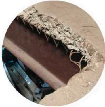
Losa de 8cm de espesor, conformada por malla metálica y hormigón proyectado, apoyada en perfiles IPN160 (dispuestos cada 80cm).
