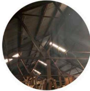
Cubierta de chapa gris galvanizada, y en algunos sectores chapa traslúcida para iluminación.
