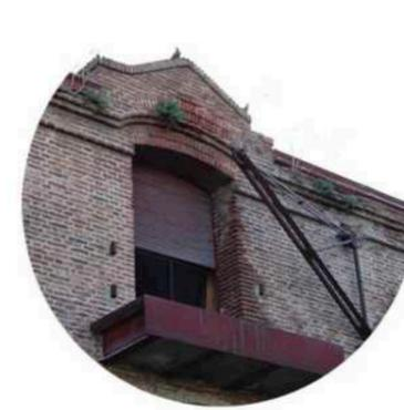
Ménsulas pescantes con brazo de 2,90m de largo, que graba por medio de bisagras, que se utilizaban para cargas a planta alta. Con balcón de vuelo.
