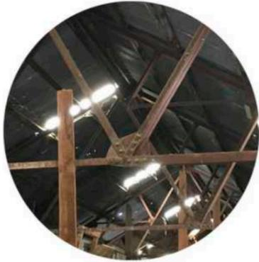
Cabreadas metálicas conformadas por perfiles L, anudadas a través de planchuelas metálicas abulonadas.
