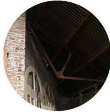
Esquinas con ángulos agudos, por el cruce de fachada longitudinal (dispuesta a 45°) y fachada paralela a línea municipal.
