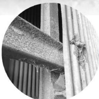
Grilla metálica con perfiles de vías ferroviarias.
