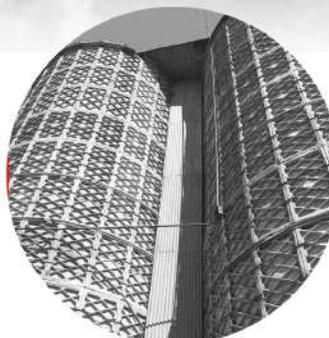
Silos de paneles de hormigón prefabricado AgroSilo.
