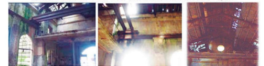
LA CUBIERTA Y EL LINTERNÓN DE LA CASA DE MAQUINAS ESTAN FORMADOS POR CABREADAS METÁLICAS, CORREAS DE MADERA Y TABLAS MACHIHEMBRADAS, MIENTRAS QUE LA ESTRUCTURA DE LOS GALPONES SE DISPONE DE RETICULADOS COMPLETAMENTE METÁLICOS. CUBIERTA DE CHAPA ONDULADA EN AMBOS CASOS , CON CERRAMIENTO LATERAL DE CHAPA EN GALPONES
