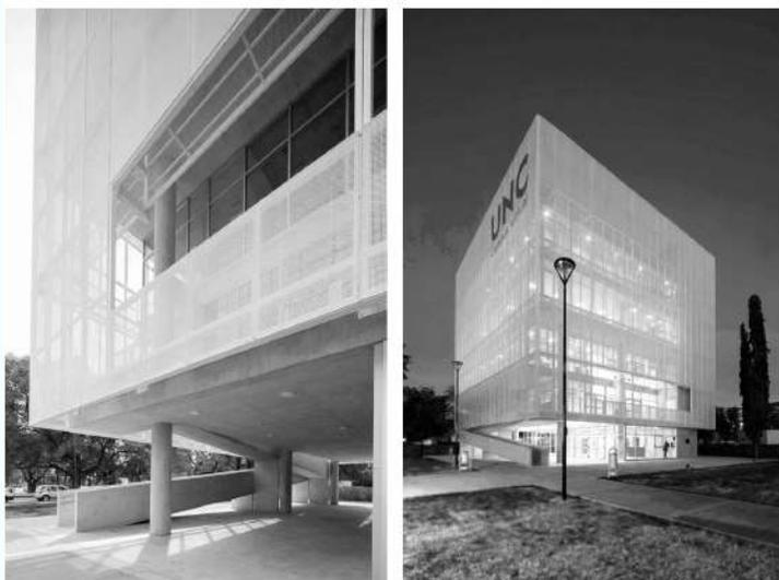
Tecnología de concreto visto como estructura portante y estructura y malla metálica como envoltente externa
