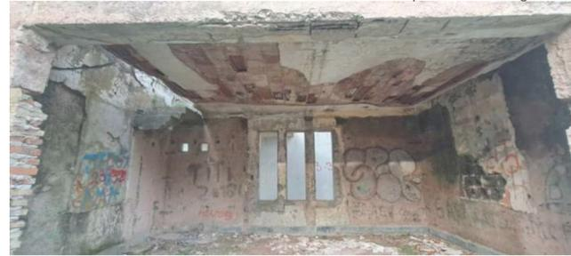
Planta baja de ala derecha: muros, losa, escalera muy deteriorados
