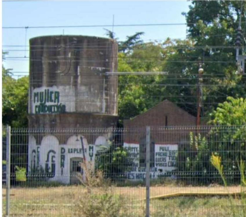
Tanques preexistentes, estos son utilizados hoy en día para abastecer a la estación. Estos tanques se reutilizarán con el agua captada por la lluvia.
