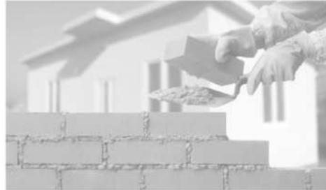
Se construirán muros de ladrillo tradicional macizo de 12 x 25 x 5cm a la vista. Se utilizará el aparejo palomero dejando huecos entre las piezas horizontales para generar filtración de luz y ventilación
