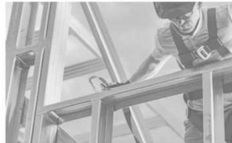
Se complementará con un constructivo industrializado basado en la utilización de perfiles estructurales de acero liviano con otros componentes de aislación, división, fijación y terminación.
