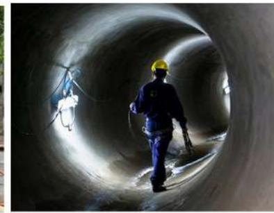
Como parte del plan de obras hidráulicas en La Plata, se ha llevado a cabo una intervención en el curso principal del arroyo del Gato. Los tramos que anteriormente se encontraban a cielo abierto y no contaban con revestimiento de hormigón han sido ensanchados y revestidos, abarcando desde la calle 143 hasta el Boulevard 1.
