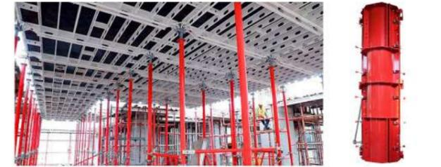
Encofrados metálicos para losas y columnas
