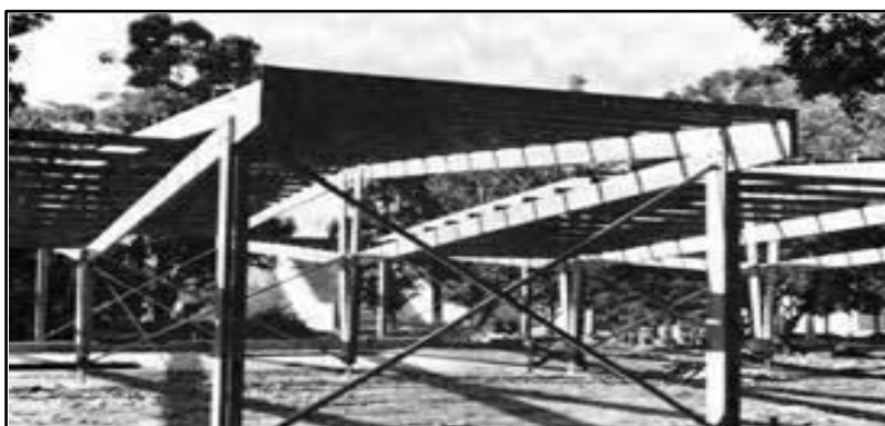
Fig. 6. Construcción de los talleres de la FAU. Año 1962. Fuente: FAU-UNLP
