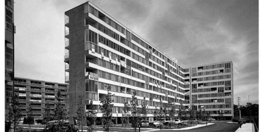
El proyecto forma parte de un plan general de vivienda publica que contemplaba la disposicion de los edificios en torno al perimetro solar y el trazado de las calles. La planta baja del edificio dispone un estacionamiento sostenido por pilotis que es permeable en todas las direcciones.
