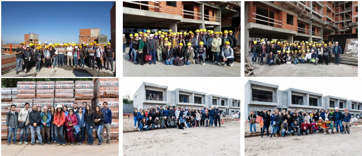
Figura | 29. Visitas a obra. Fuente: Archivo propio. 2022.
