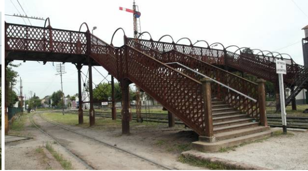
Puente de Hierro que cruza las vías sobre calle 528
