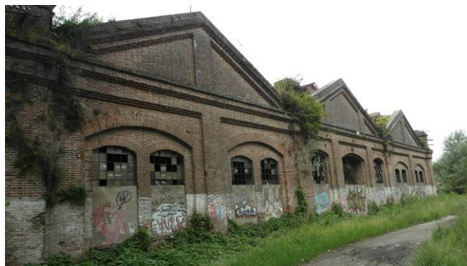
Taller de ladrillo y techo de tejas
