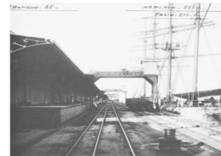
Muelle Gran Dock, 1920
