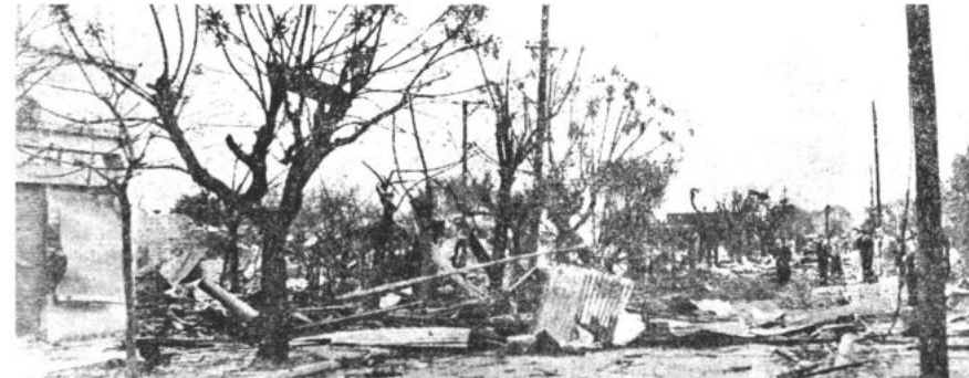
Destrozos en Barrio Campamento (El Argentino 17/09/1955)
