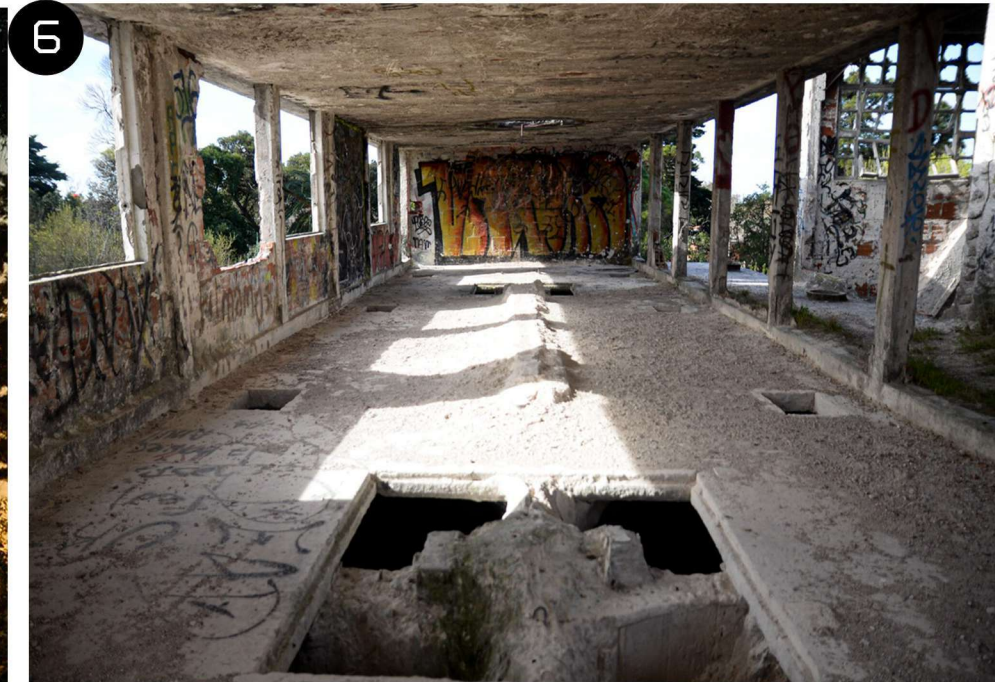
6. CHIMENEAS COMO HITO URB. 7. INTERIOR DESDE 2DO NIVEL POR ENCIMA DE LOS SILOS
