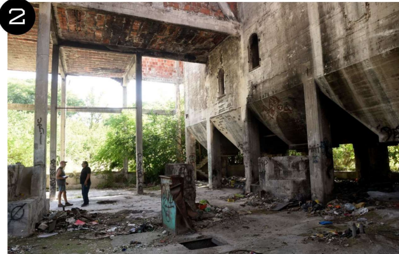
2. INTERIOR DE LA FABRICA - VISTA DE LOS SILOS
