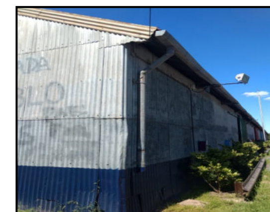
Cerramiento vertical exterior de chapa acanalada
