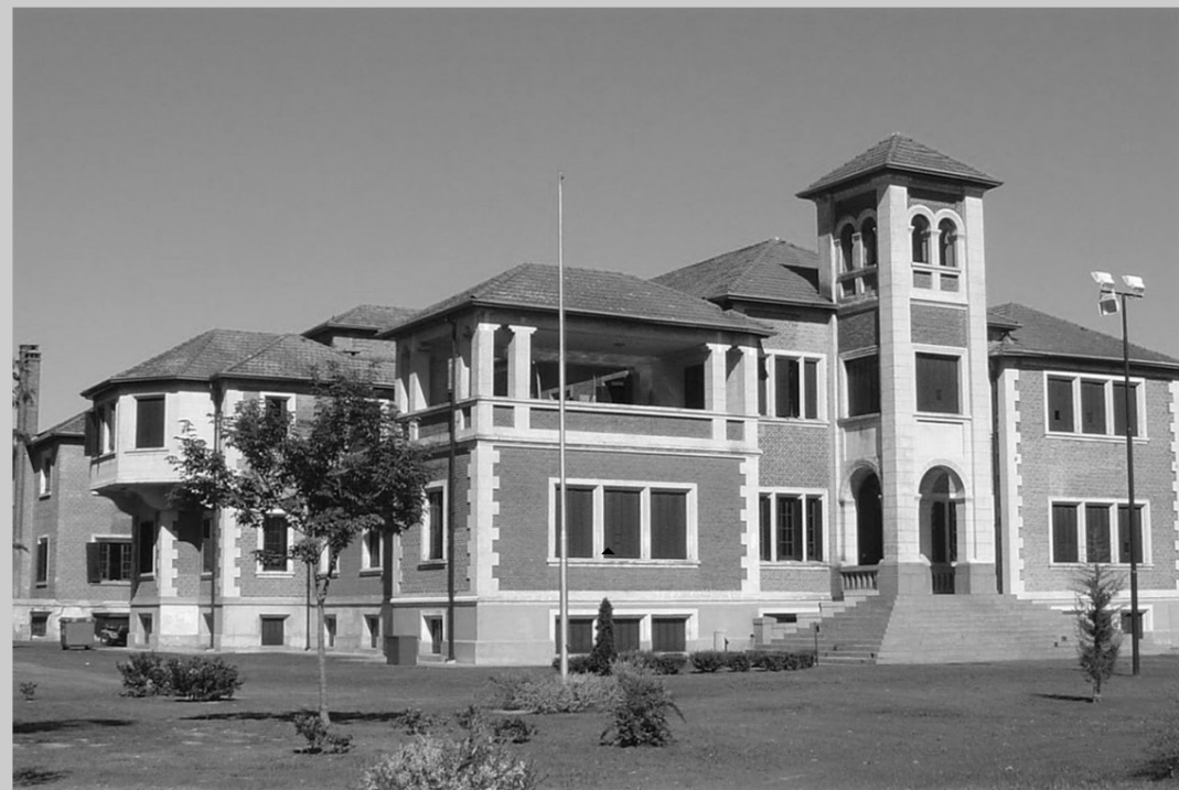
▲ Edificio de carácter patrimonial: Conservatorio de música Gilardo Gilardi, La Plata, Buenos Aires, Argentina.
