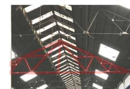
ESTRUCTURA DE CUBIERTA Cabiada metálica de perfiles L, anudadas a través de planchuelas metálicas abulonadas.
