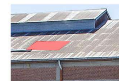
CUBIERTA Está conformada por chapa gris galvanizada y chapa traslucida que deja pasar la luz.
