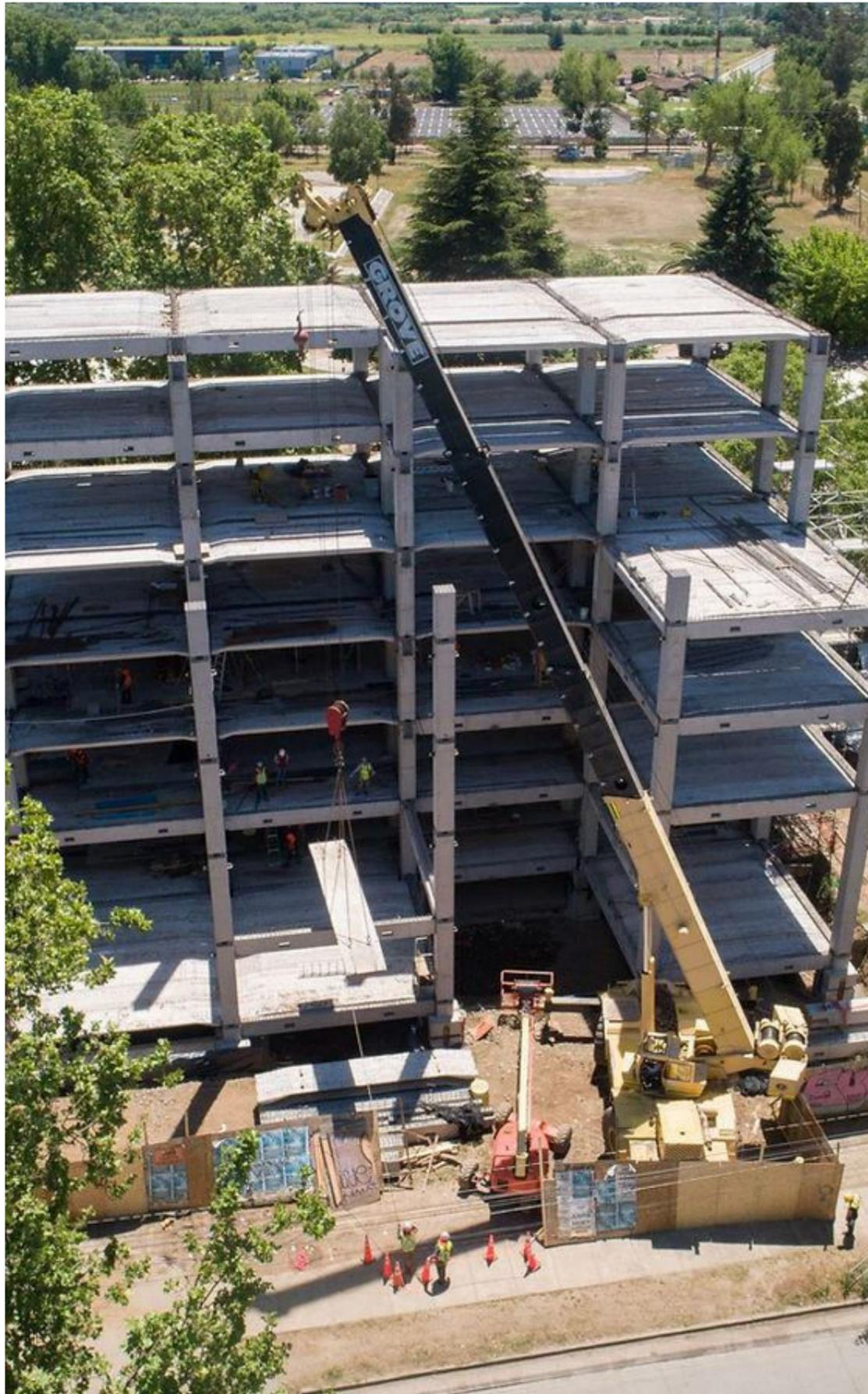
Se trata de un sistema de construcción industrializado que utiliza técnicas y procesos más innovadores y en el cual los componentes estructurales se fabrican en un taller, se transportan a la ubicación final y allí se ensamblan. Basado en la precisión y en la rapidez que los elementos se montan en la obra.
