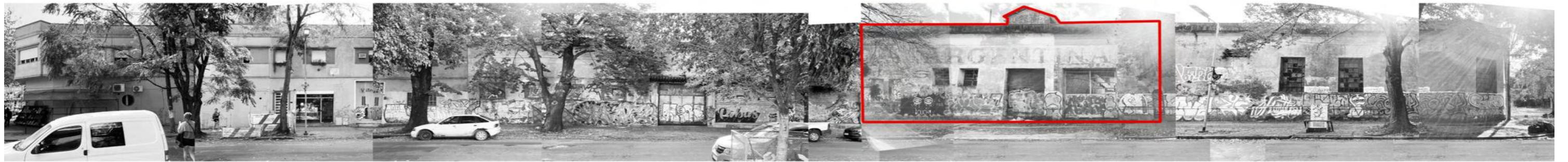
reconstrucción de fachada calle 46
