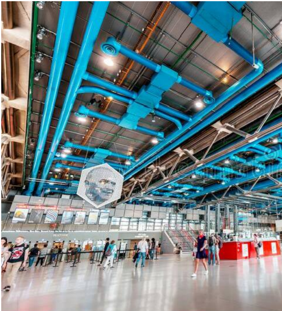
Centro Pompidou - Piano-Rogers
