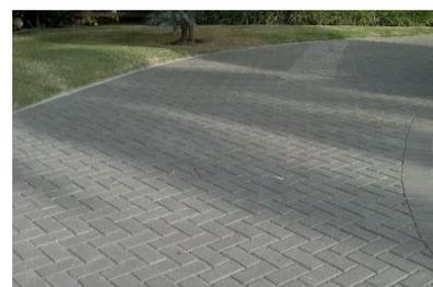
*Bloques verde block* para los estacionamientos de autos. Son bloques de hormigón vibrado y comprimido de alta resistencia. Se decidió su utilización, con el fin de constituir un solado permeable al paso del agua, para disminuir la cantidad de pavimento y obtener mayor superficie absorbente. Estos adoquines son absorbentes y naturales, y altamente resistentes al tránsito de vehículos.
