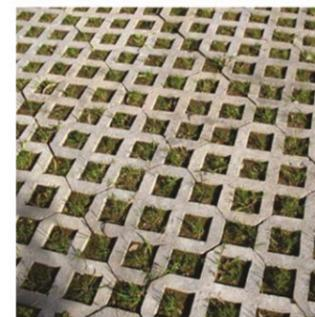
Bloques verde block, para estacionamientos de autos. Poseen alta resistencia y permiten un solado permeable al paso del agua.
