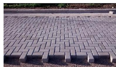
La característica de su elaboración y la ausencia de juntas asfálticas, lo hacen totalmente inalterable a la acción de combustibles y otras sustancias corrosivas. Además, la textura de su cara superior es antiderrapante, evitando así el riesgo de patinadas sobre superficies húmedas.
